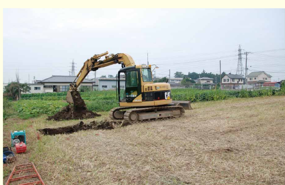
第7図 トレンチ掘削調査の様子。ショベルカーで断層崖に対して直交した向きに溝（トレンチ）を掘ります。
