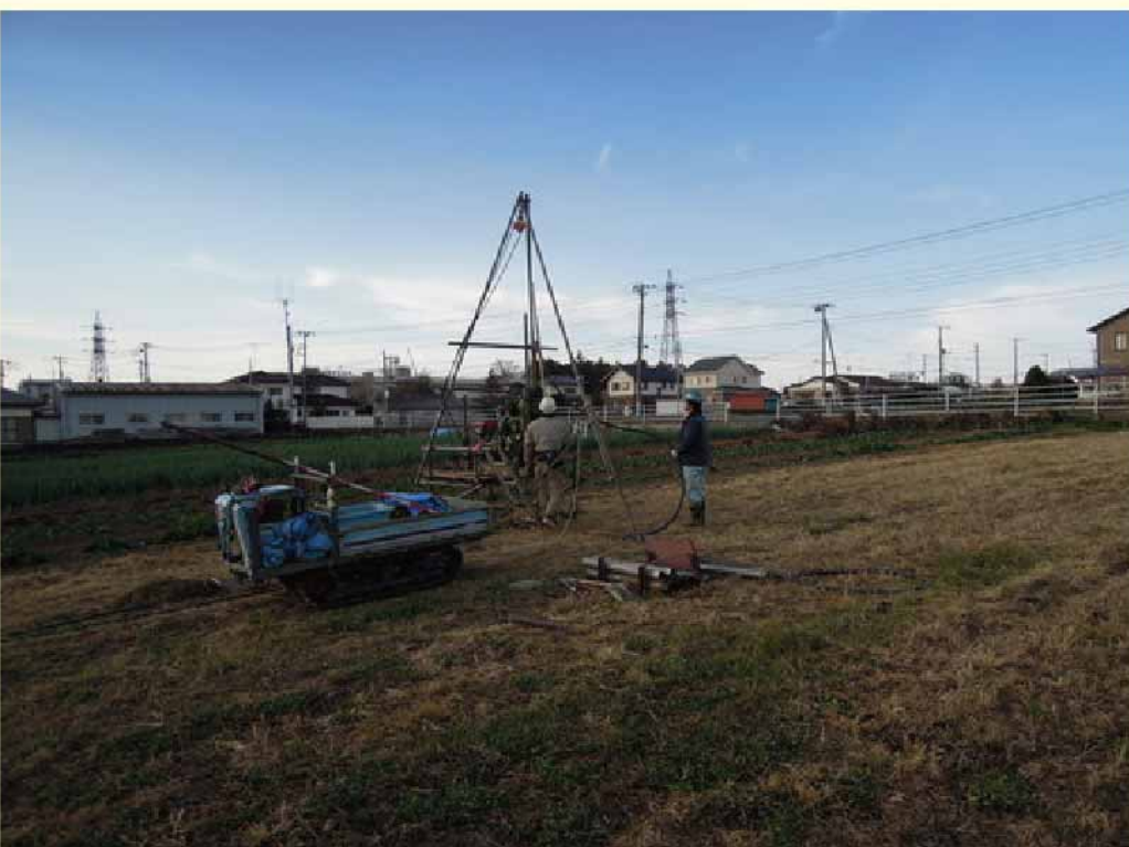
第4図 ボーリング調査の様子。やぐらを組み、金属の管を地中にいれていき、その地点の地層を抜き取ります。
