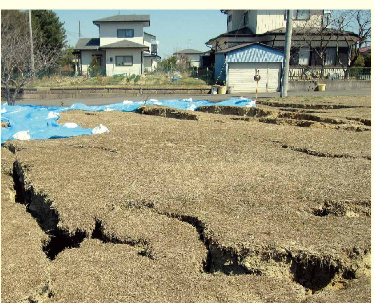
第9図 宅地盛土に発生した地割れ (2011年東北地方太平洋沖地震)
