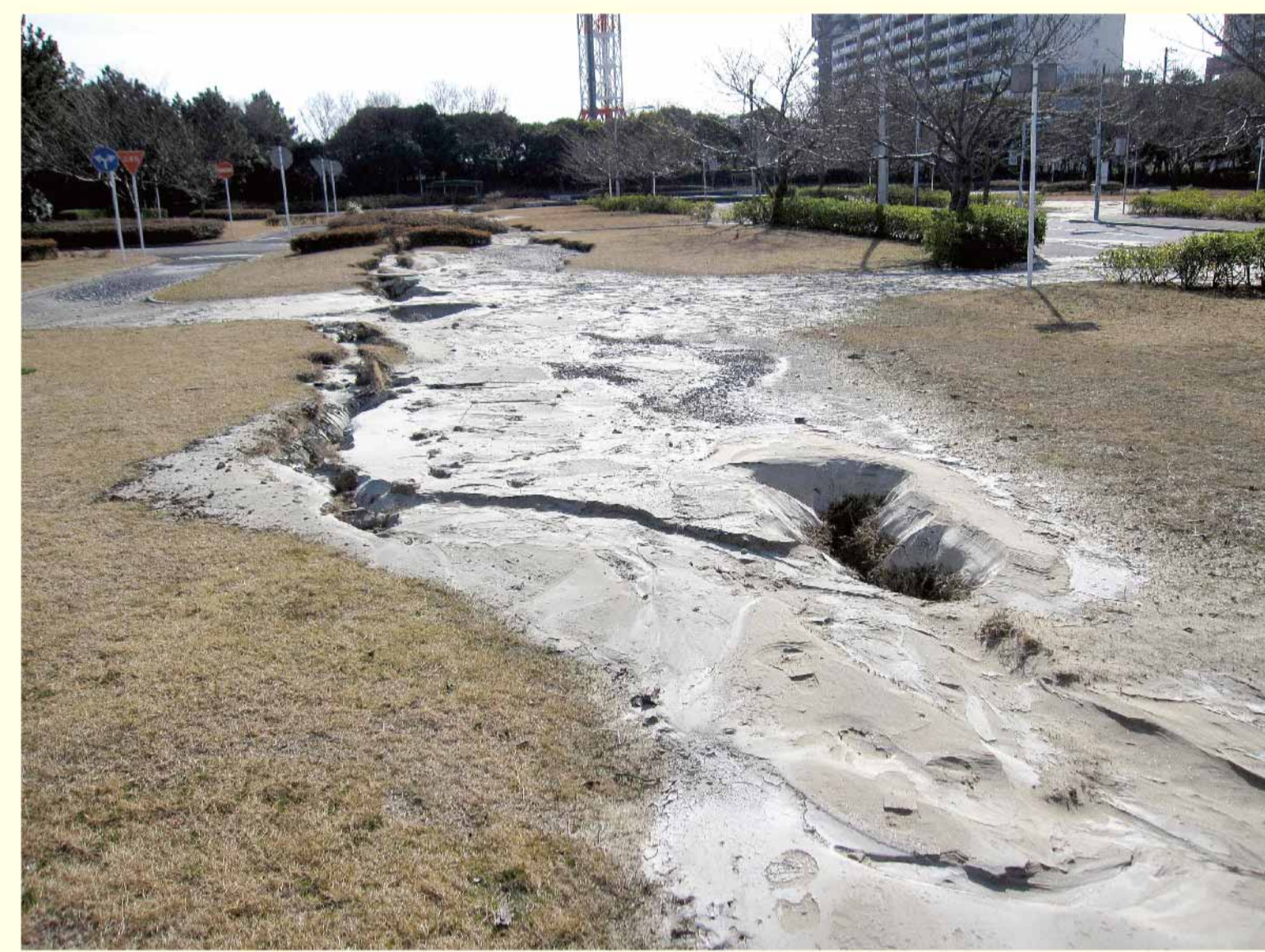
第5図 地割れから噴き出した液状化した砂 (2011年東北地方太平洋沖地震)
