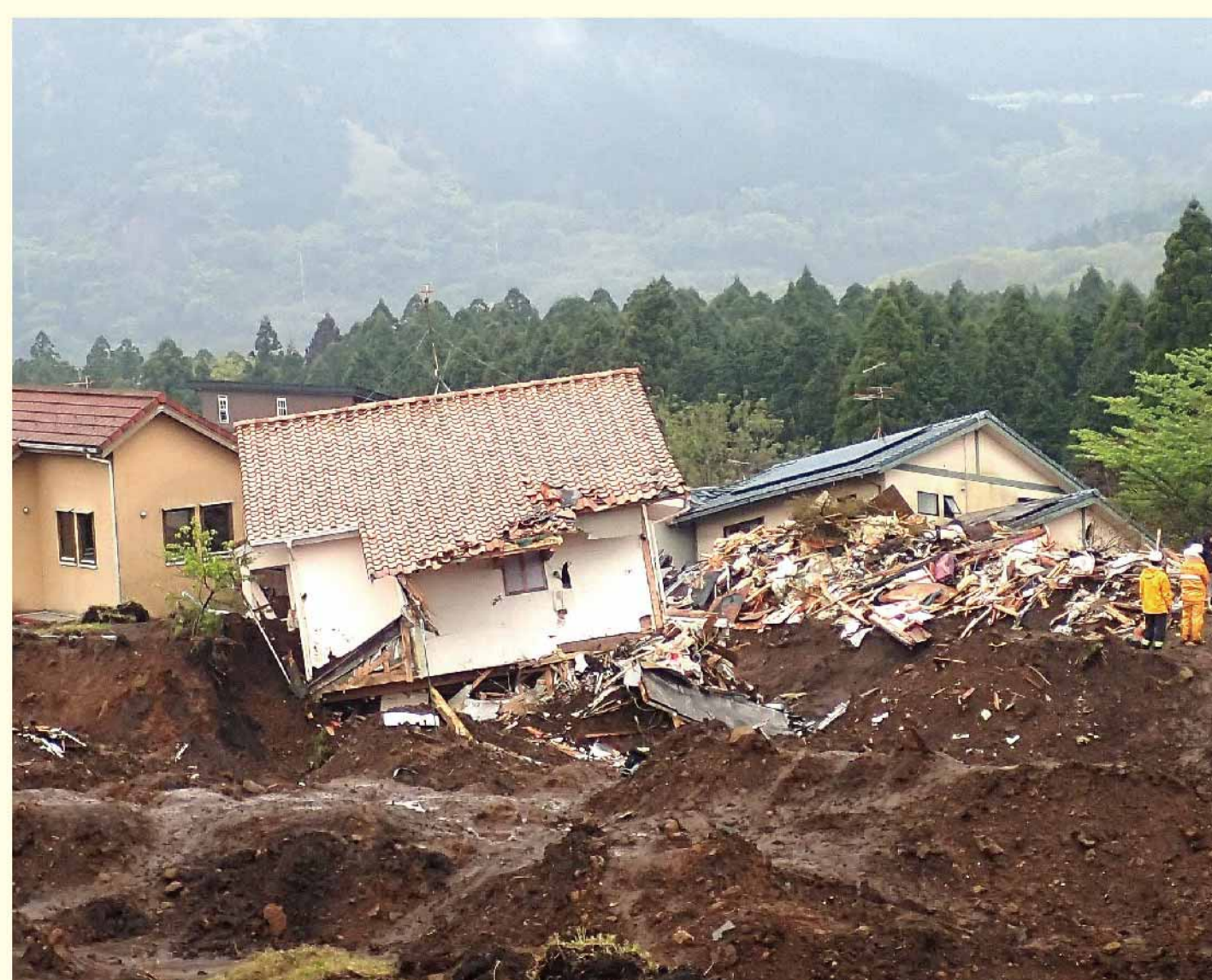
第10図 斜面崩壊の土砂の直撃を受けた家屋 (2016年熊本地震)
