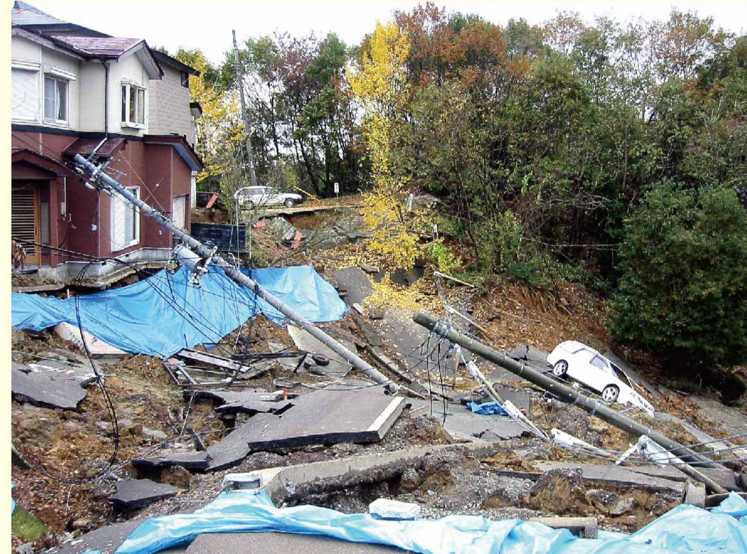
第5図 宅地盛土斜面の崩壊 (2004年新潟県中越地震)
