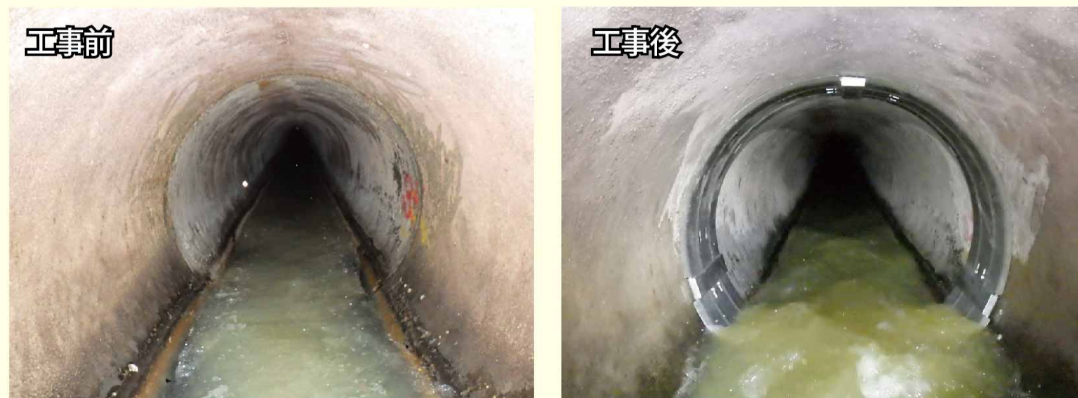
第6図 下水管渠の耐震化 (提供: 群馬県)
