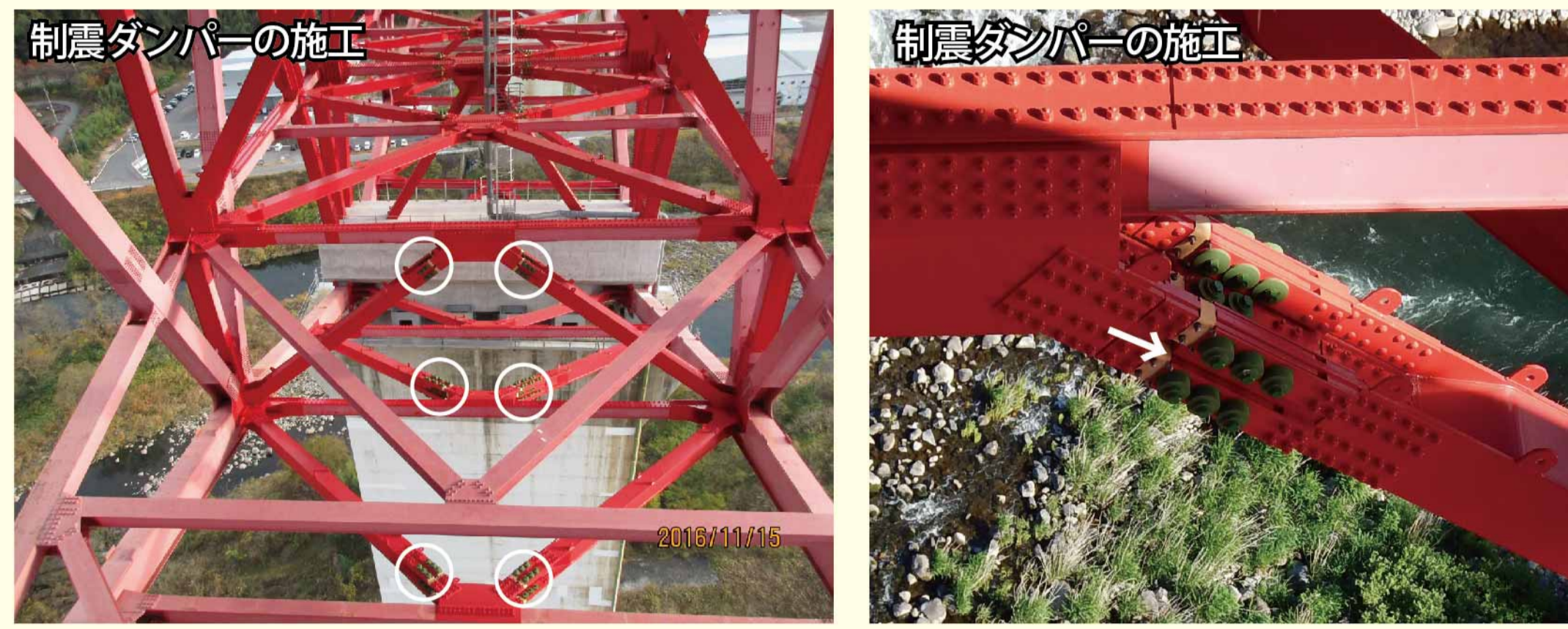
第3図 高速道路橋の耐震補強 (提供: 東日本高速道路株式会社)
