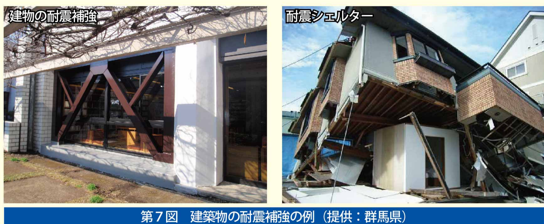
第7図 建築物の耐震補強の例 (提供: 群馬県)
